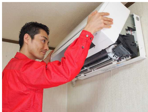
エアコンクリーニング
