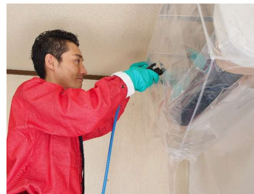
エアコンクリーニング
