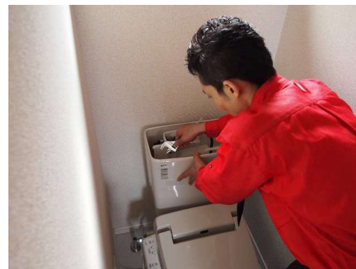
ロータンク修理
